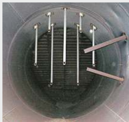
Einblaslanzen im Abgaskanal
