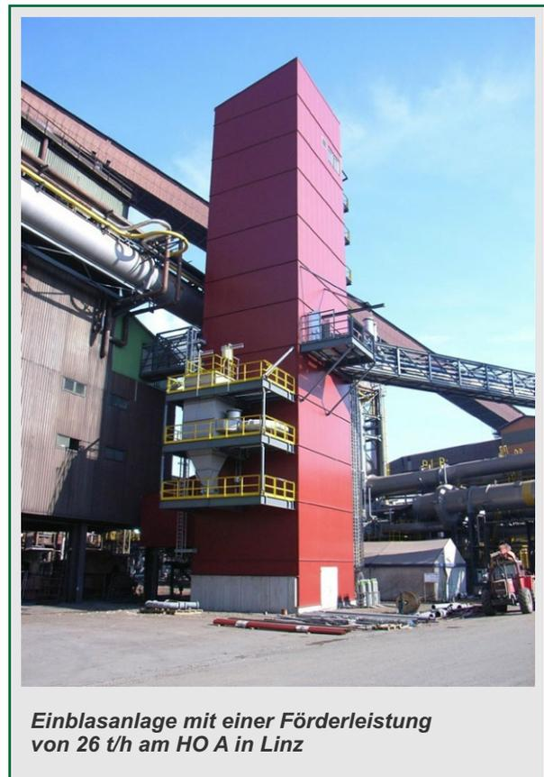
*Einblasanlage mit einer Förderleistung von 26 t/h am HO A in Linz*
